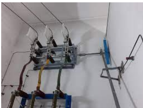
[Réparation et remise en état d'intersec]
